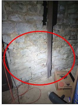
Deteriorating/Failing Mortar:
